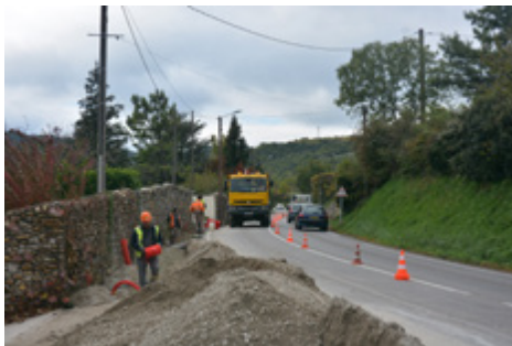
RD86 : Travaux de rénovation des réseaux et de reprise du revêtement de l'entrée Nord de Saint-Péray jusqu'à la rue Oscar Saint-Prix. Aménagement d'un nouveau carrefour à feux au débouché de la rue Cassin. Travaux réalisés sous la maîtrise d'ouvrage du conseil départemental, de la CCRC et du syndicat mixte
